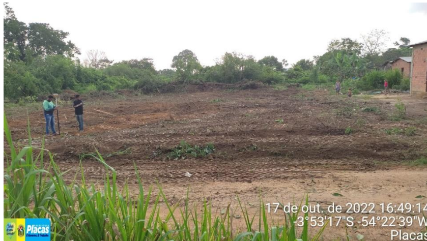
Foto 2 – Terreno a ser implantado o Sistema de abastecimento de Água
